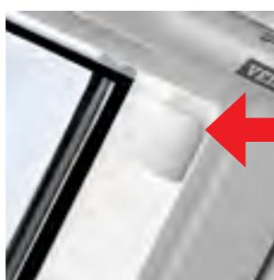
Předinstalované montažní úchyty jsou součástí všech nových oken VELUX. Montáž vnitřních stínících doplňků je s nimi ještě snadnější!
