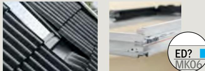
Ilustrace: zapuštěná instalace do krytiny EDJ.
