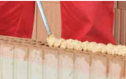
Technologie na zdicí pěnu Porotherm Dryfix
