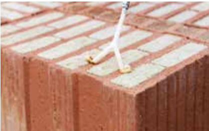
Technologie na lepidlo pro zdění Porotherm Dryfix. extra
